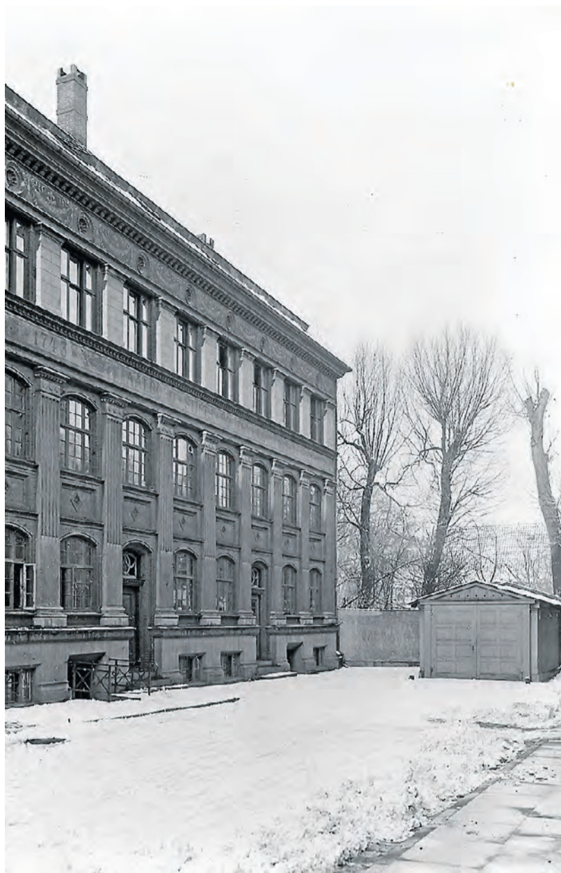
Bernhard Rées Gade 1, vinteren 1933. På bygningen står "1743 Aalborg Stifts Bogtrykkeri".
